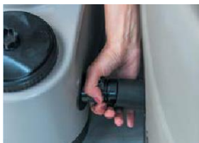
8) Připojte čerpací jednotku k vířivce pomocí 3 šroubovacích konektorů. Zkontrolujte, zda se značení na čerpadle a na vířivce shoduje.
